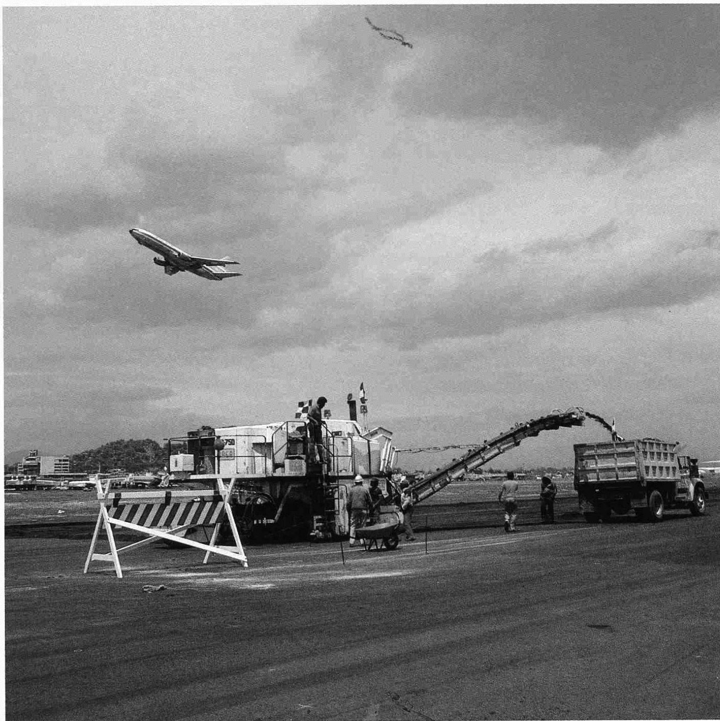
Personal y maquinaria de IASA en los trabajos de compactación de la carpeta asfáltica.
